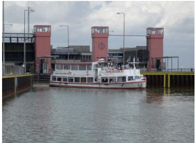
Foto: Fahrgastschiff Elvkieker II am Schiffshebewerk Scharnebeck
